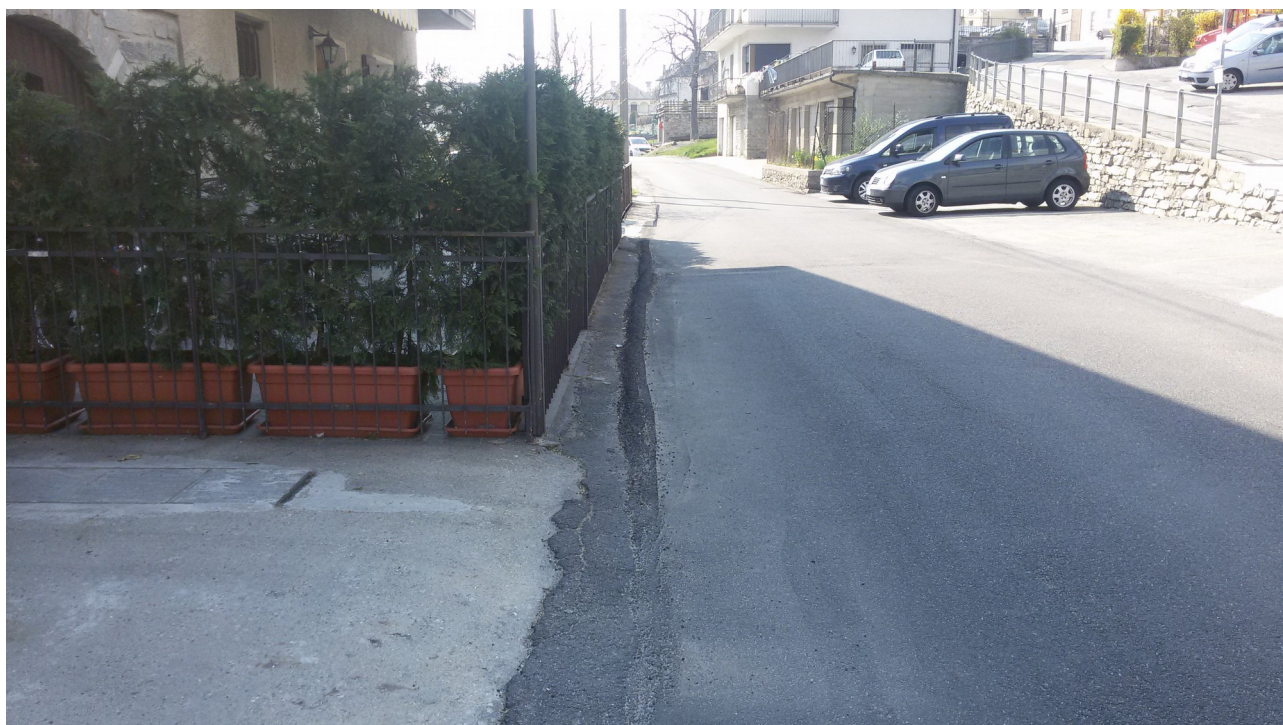
Zona esecuzione di cunetta stradale
