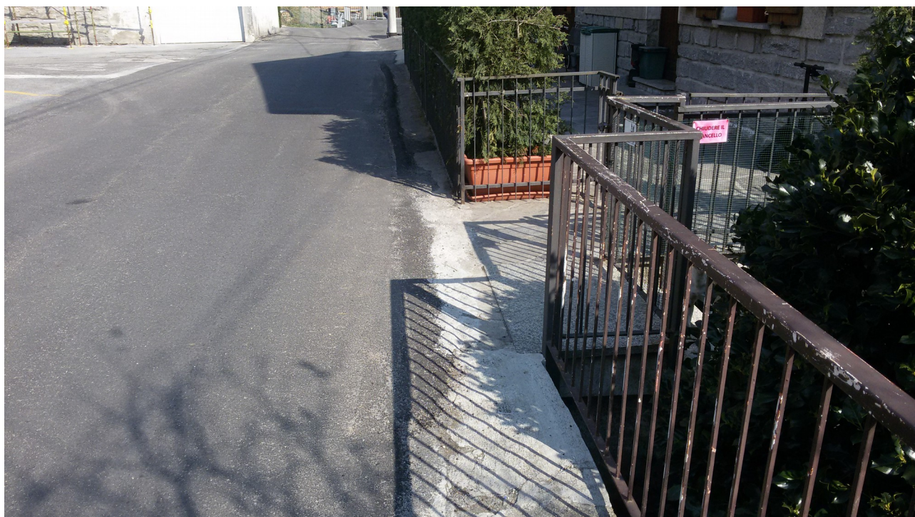
Zona di posa della canaletta con grigliato
